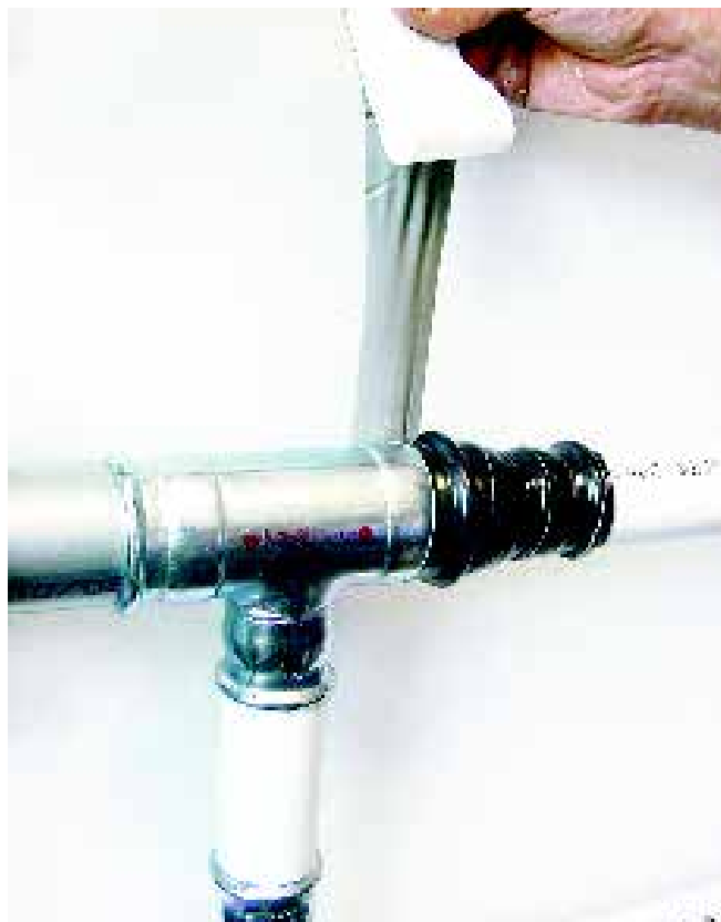
Obr. 35 – Ochrana spojů butanolovou lepicí páskou
