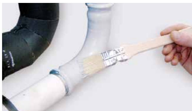
Obr. 34 – Lakování přípojek a trubek základním nátěrem
