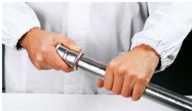
Obr. 31 – Zavádění trubky do lisovací tvarovky
