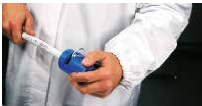
Obr. 29 – Odstranění pláště (steelPRES s pláštěm z
