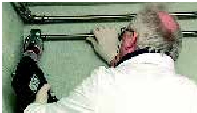
Obr. 32 – Zhotovení lisovaného spojení
